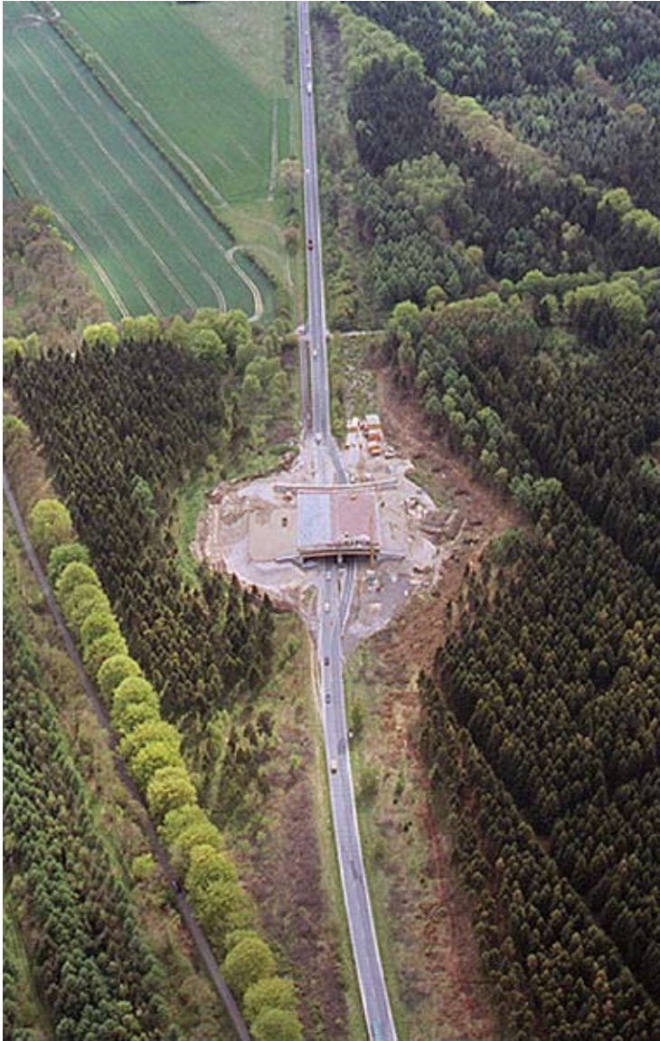
Abb. 2: Grünbrücke in Bau an der A 21 in Schleswig-Holstein. (Foto: M. Meißner)
